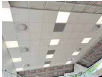
Op de foto ziet u het nieuwe plafond van de aula. Een plafondsysteem dat ook in de klaslokalen komt.
