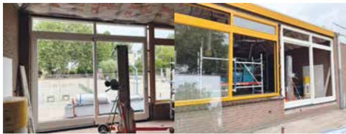
Het eerste klaslokaal waar de schuifpui geplaatst is. Met een schuifpui kunnen we binnen en buiten makkelijker en meer met elkaar verbinden.
